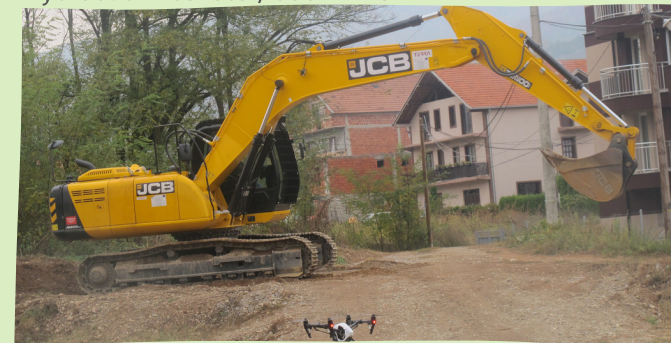
Hydraulic Excavator, Gadzin Han
